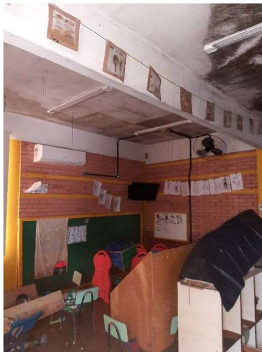
Foto 65 e foto 66. Luminárias no teto com bastante umidade/mofo
