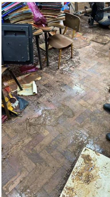
Fotos 22 e 23. Interior da Escola - paredes e pisos avariados pela enchente.
