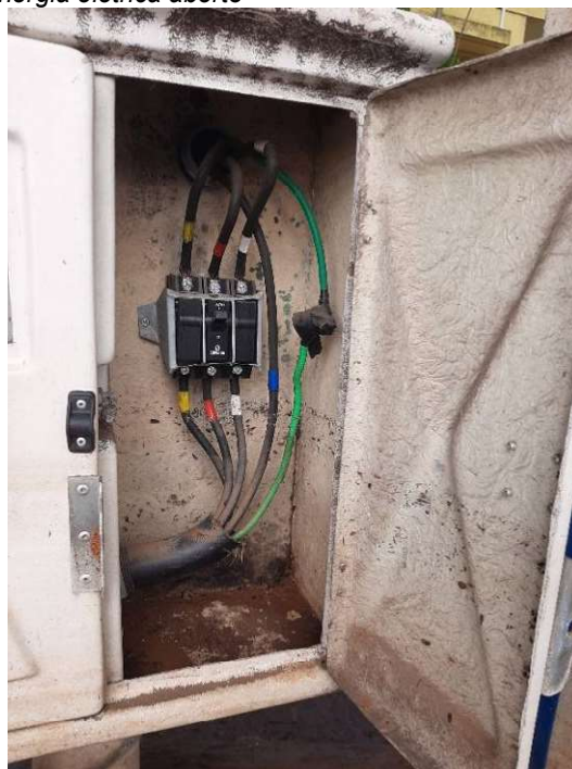
Foto 55 e foto 56. Medidor de energia elétrica com marcação da água abaixo do disjuntor geral
