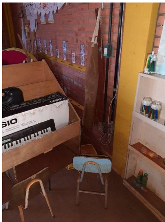
Foto 60 e foto 61. Eletrodutos e tomadas baixas molhadas, deverão ser substituídas
