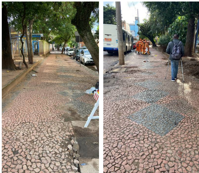
Fotos 01 e 02. Calçadas de acesso a Escola.
