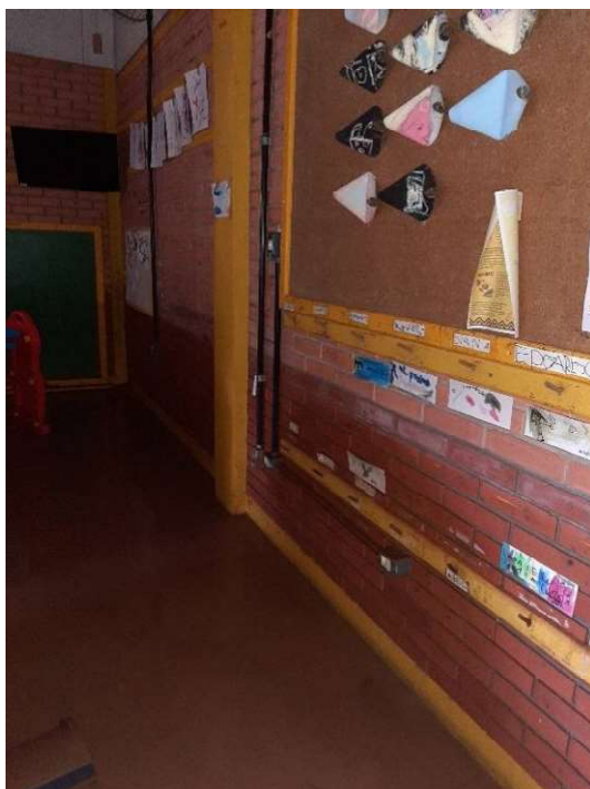
Foto 60 e foto 61. Eletrodutos e tomadas baixas molhadas, deverão ser substituídas
