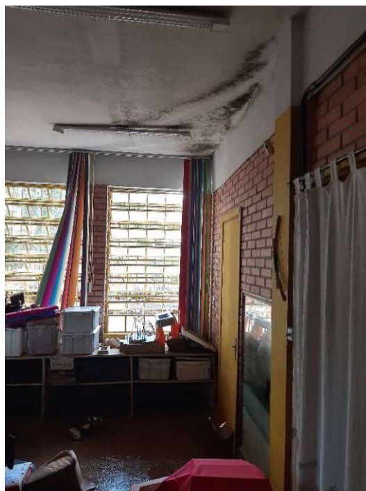
Foto 67 e foto 68. Luminárias no teto com bastante umidade/mofo
