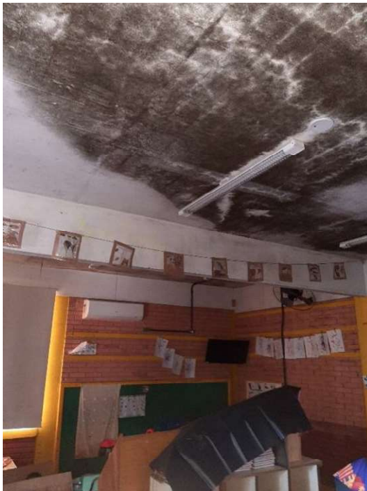
Foto 63 e foto 64. Luminárias no teto com bastante umidade/mofo
