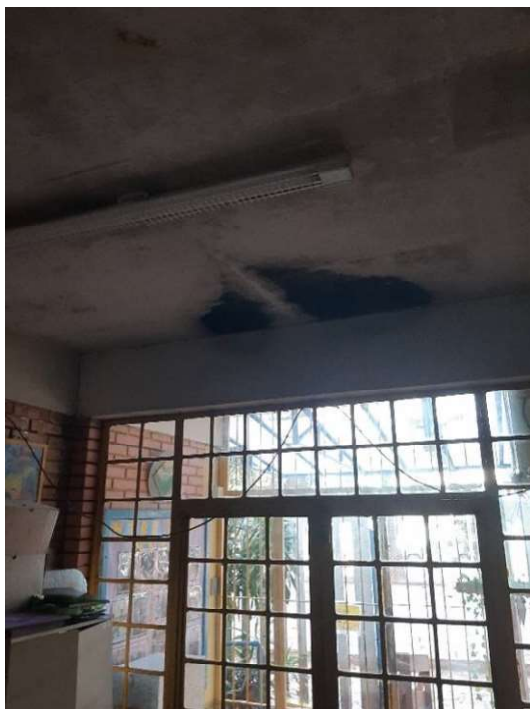
Foto 69 e foto 70. Luminárias no teto com bastante umidade/mofo
