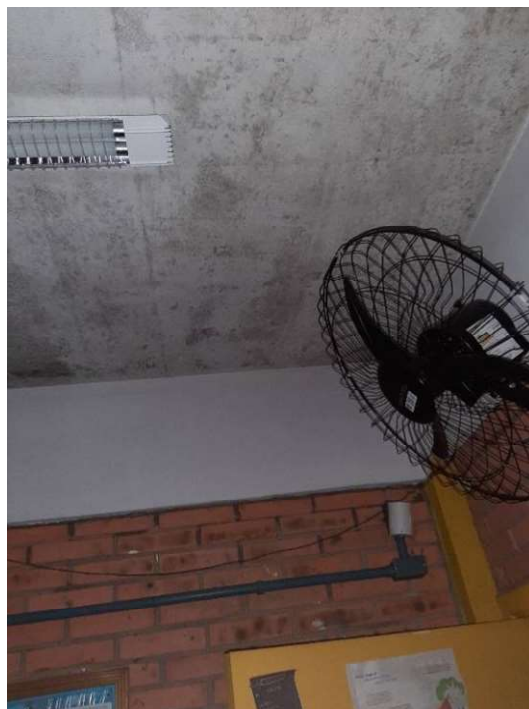
Foto 69 e foto 70. Luminárias no teto com bastante umidade/mofo
