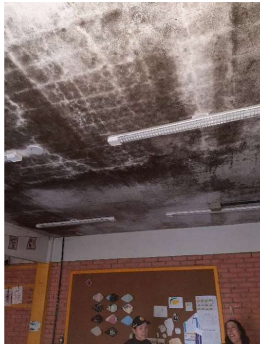
Foto 63 e foto 64. Luminárias no teto com bastante umidade/mofo
