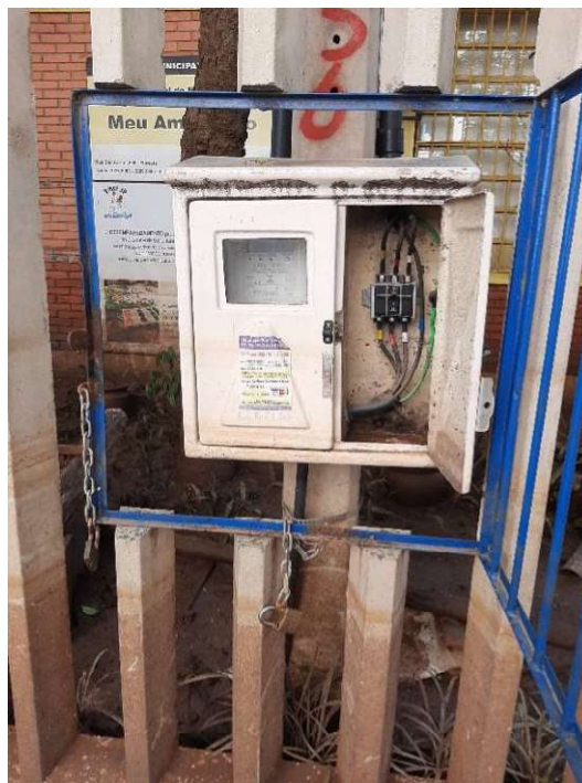
Foto 53. Medidor de energia elétrica
