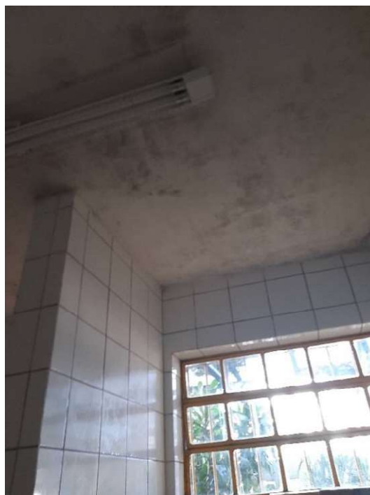
Foto 71 e foto 72. Luminárias no teto da cozinha com bastante umidade/mofo
