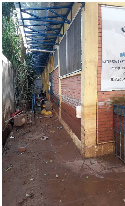
Foto 40. Fundos da Escola – piso de basalto e guarda corpos da acessibilidade avariados.
