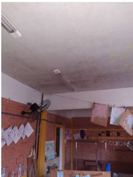
Foto 67 e foto 68. Luminárias no teto com bastante umidade/mofo
