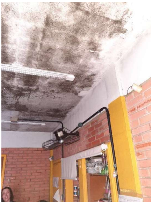
Foto 65 e foto 66. Luminárias no teto com bastante umidade/mofo
