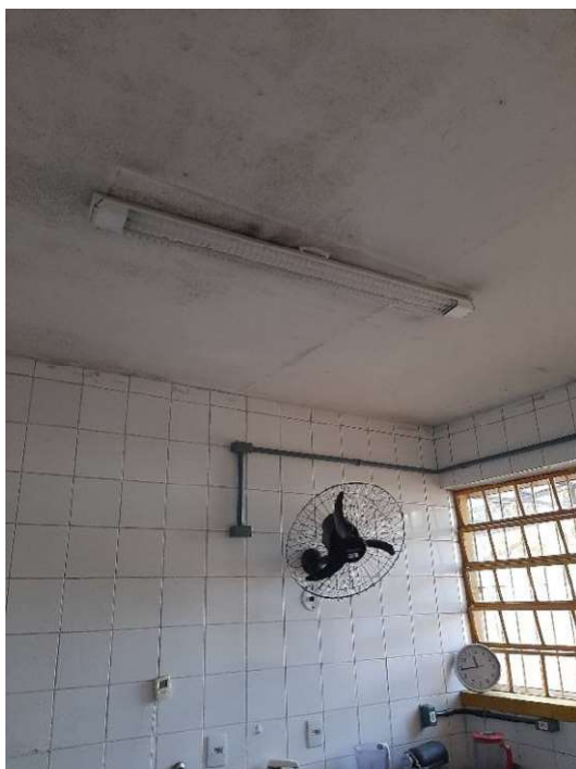
Foto 71 e foto 72. Luminárias no teto da cozinha com bastante umidade/mofo
