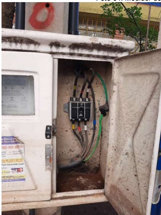
Foto 55 e foto 56. Medidor de energia elétrica com marcação da água abaixo do disjuntor geral
